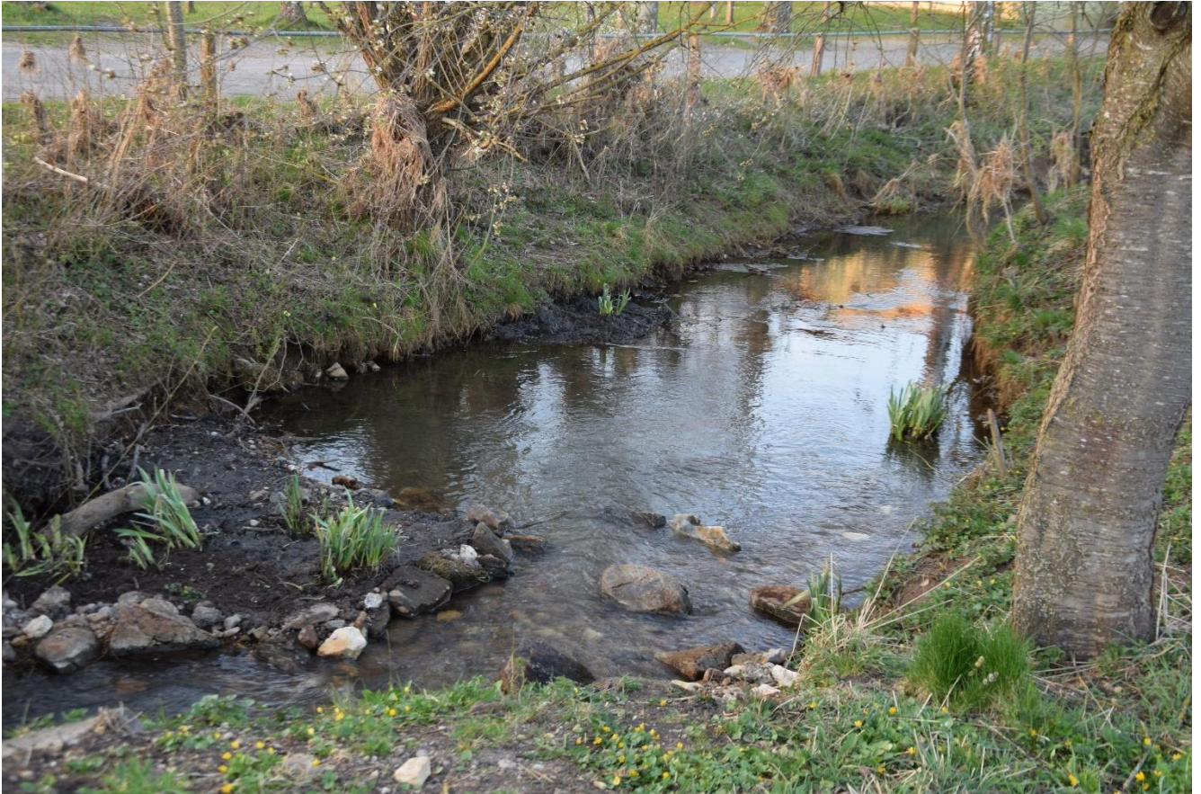
2021 – künstliche Verengung des Bulzengraben zur Veränderung der Fließgeschwindigkeit
