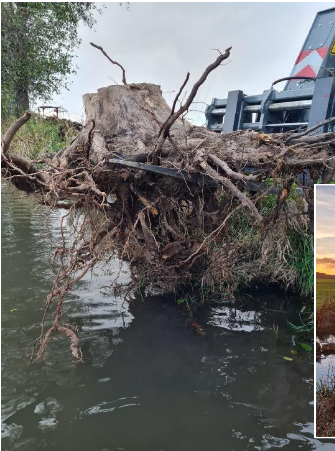
2022 – Im Gutterquellgraben werden Baumwurzeln als Unterstand eingebracht.
