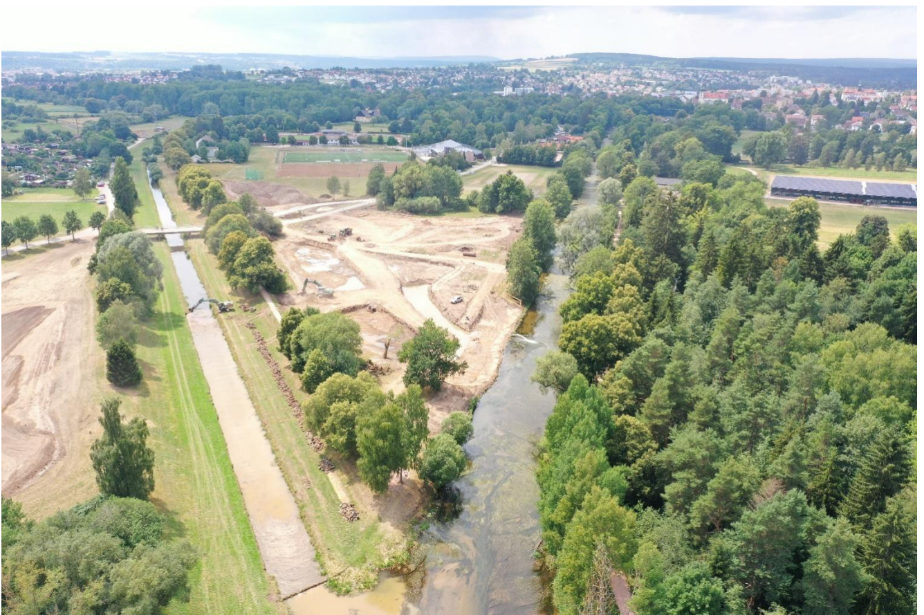
Luftaufnahme vom 22.07.2020 / Quelle: Hydra Institut
