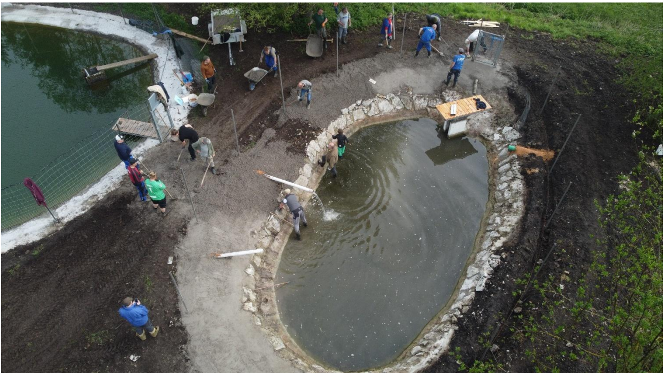
Mitglieder bei den Sanierungsarbeiten am unteren Becken im Jahr 2023 – Aufwand 220 Stunden
