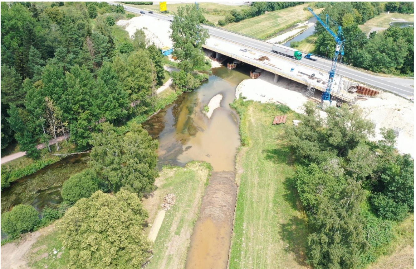
Luftaufnahme vom 22.07.2020 / Quelle: Hydra Institut
