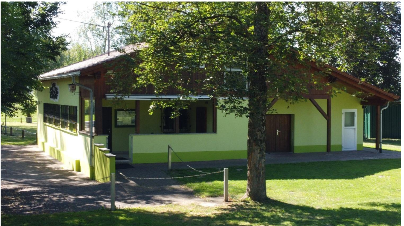
2023 wird der Boden neu verlegt und im Jahr 2024 erhält das Vereinsheim einen neuen Anstrich für das bevorstehende 100-jährige Jubiläum. Insgesamt wurden über 850 Arbeitsstunden geleistet.
