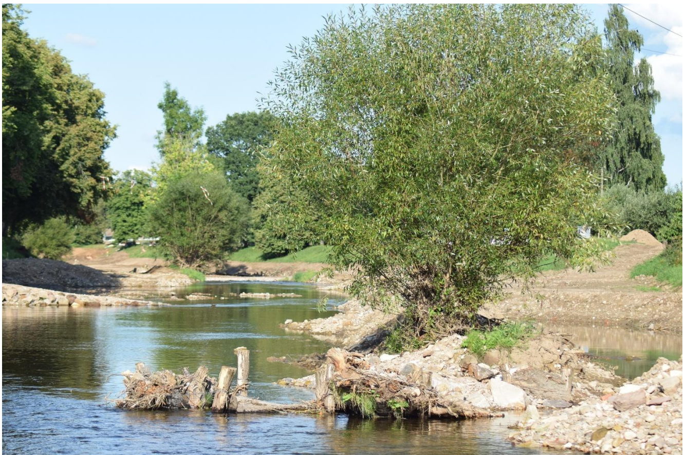
Breg im Bereich Haberfeld im August 2021 – mit Pfahlbuhnen
