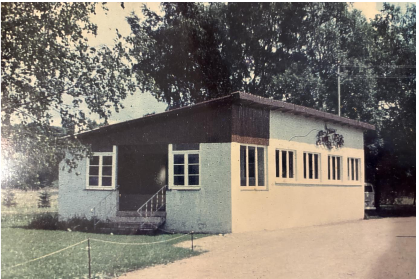
Im Jahr 1963 wird das Haus von insgesamt 42 Helfern in 2.737 Arbeitsstunden umgebaut
