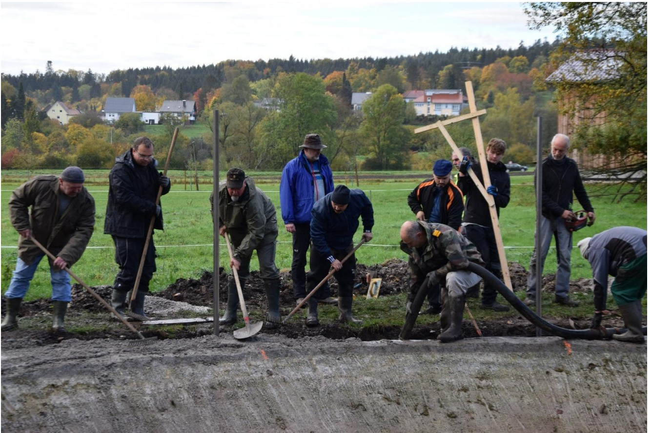
Betonierarbeiten am oberen Becken im Jahr 2022 – Aufwand 250 Stunden
