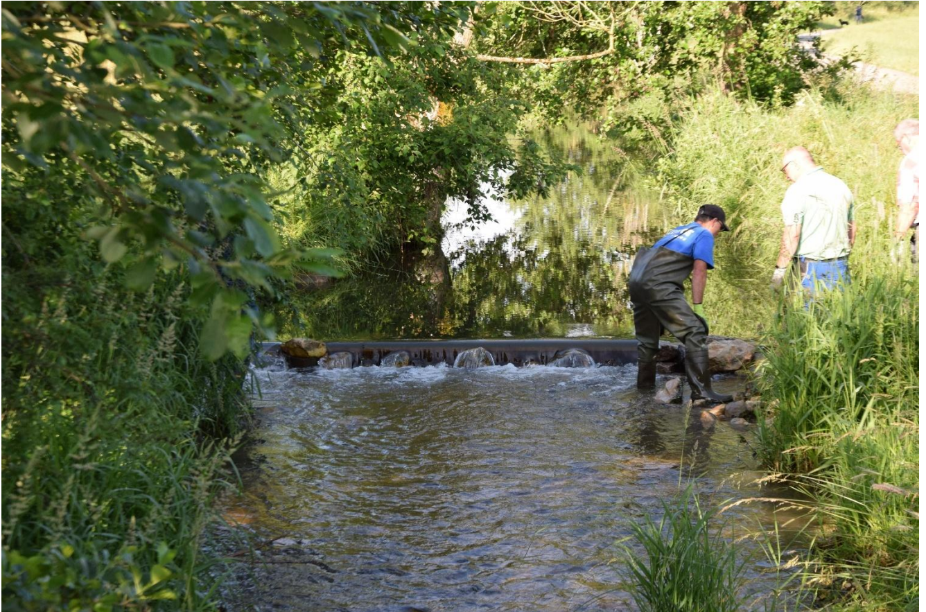
Gutterquellgraben 2022 vorher: kein Durchkommen mehr für Bachforellen und andere Fischarten
