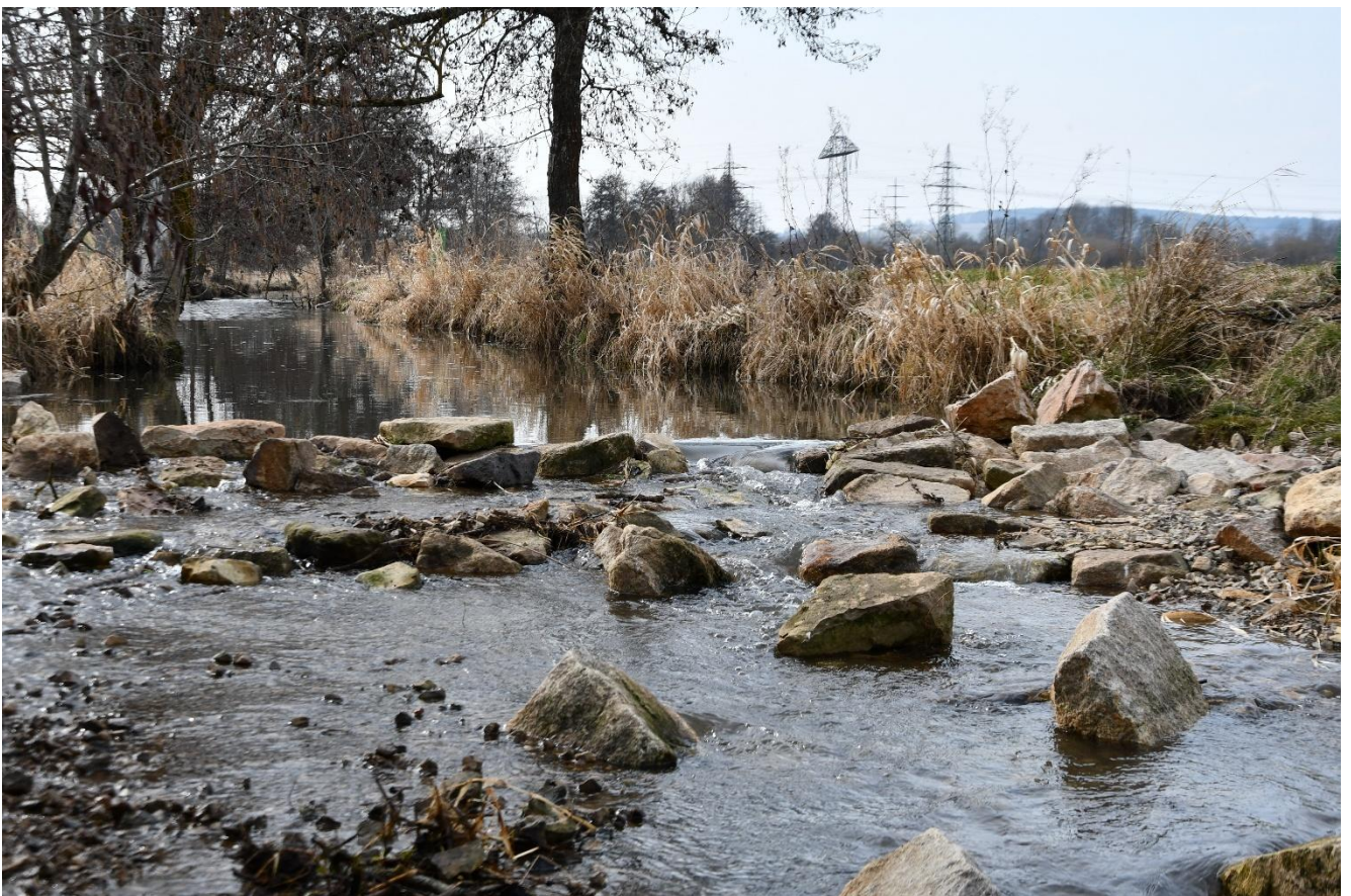
Gutterquellgraben 2022 nachher: Durch den Bau der Rampe können die Fische nun bei jedem Wasserstand zu ihren Laichplätzen aufsteigen.
