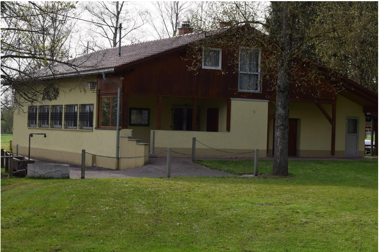
Das Vereinsheim nach der Renovierung im Jahr 1990 nach 4.596 Arbeitsstunden, die 89 Helfer erbracht haben.
