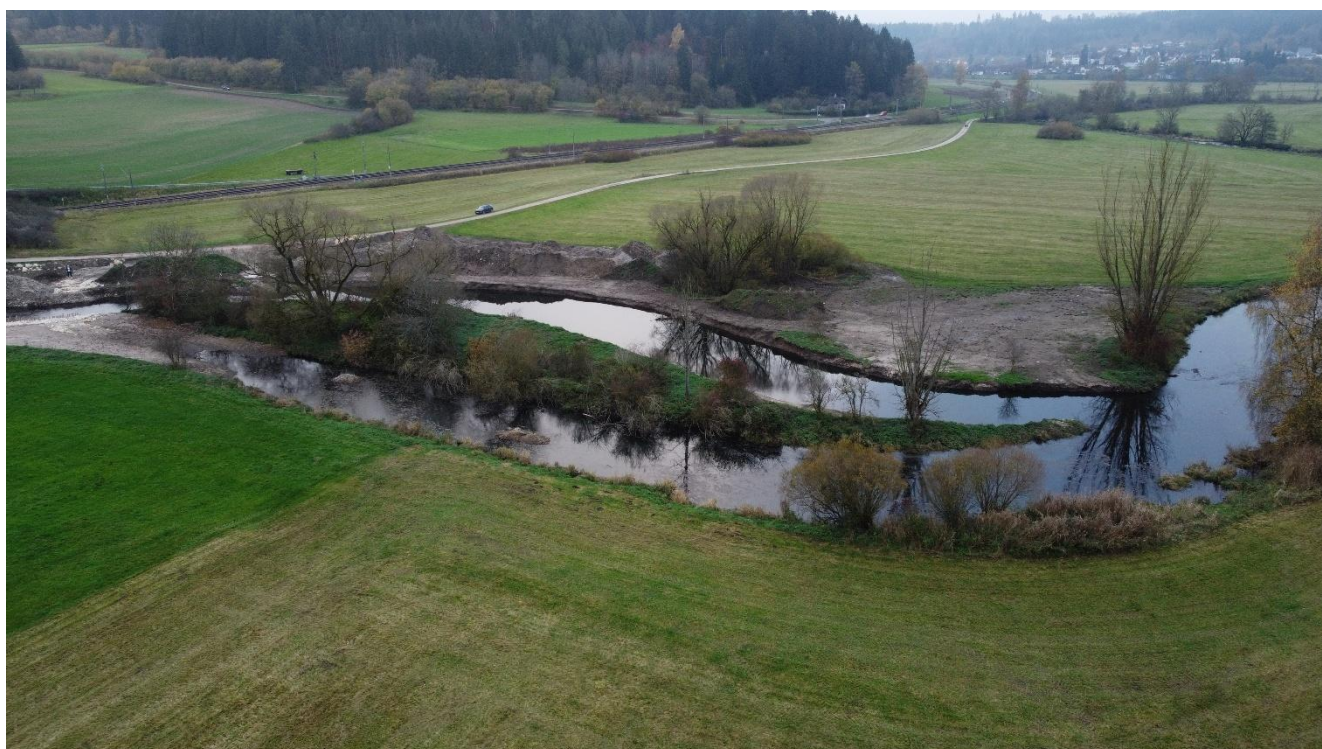
Brigach bei Aufen: Aufnahme vom November 2024 nach Abschluss der Baumaßnahme
