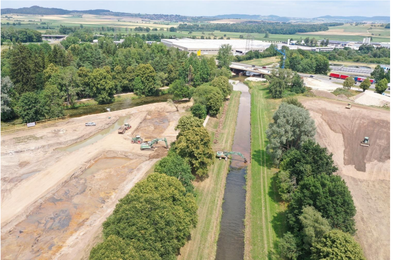
Luftaufnahme vom 22.07.2020 / Quelle: Hydra Institut
